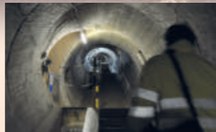
Percorso in diga Robiei Lehrpfad in der Staumauer
